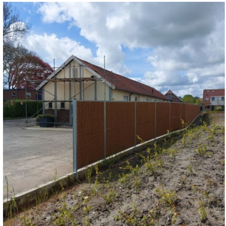
Het geluidscherm is geplaatst, aan beide zijden komt nog klimop begroeiing.
